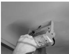
**OBS.:** Para a fixação, sugere-se o uso de parafusos de Inox, arruela dentada e, em casos de estrutura metálica, que a mesma esteja isenta de ferrugem.
